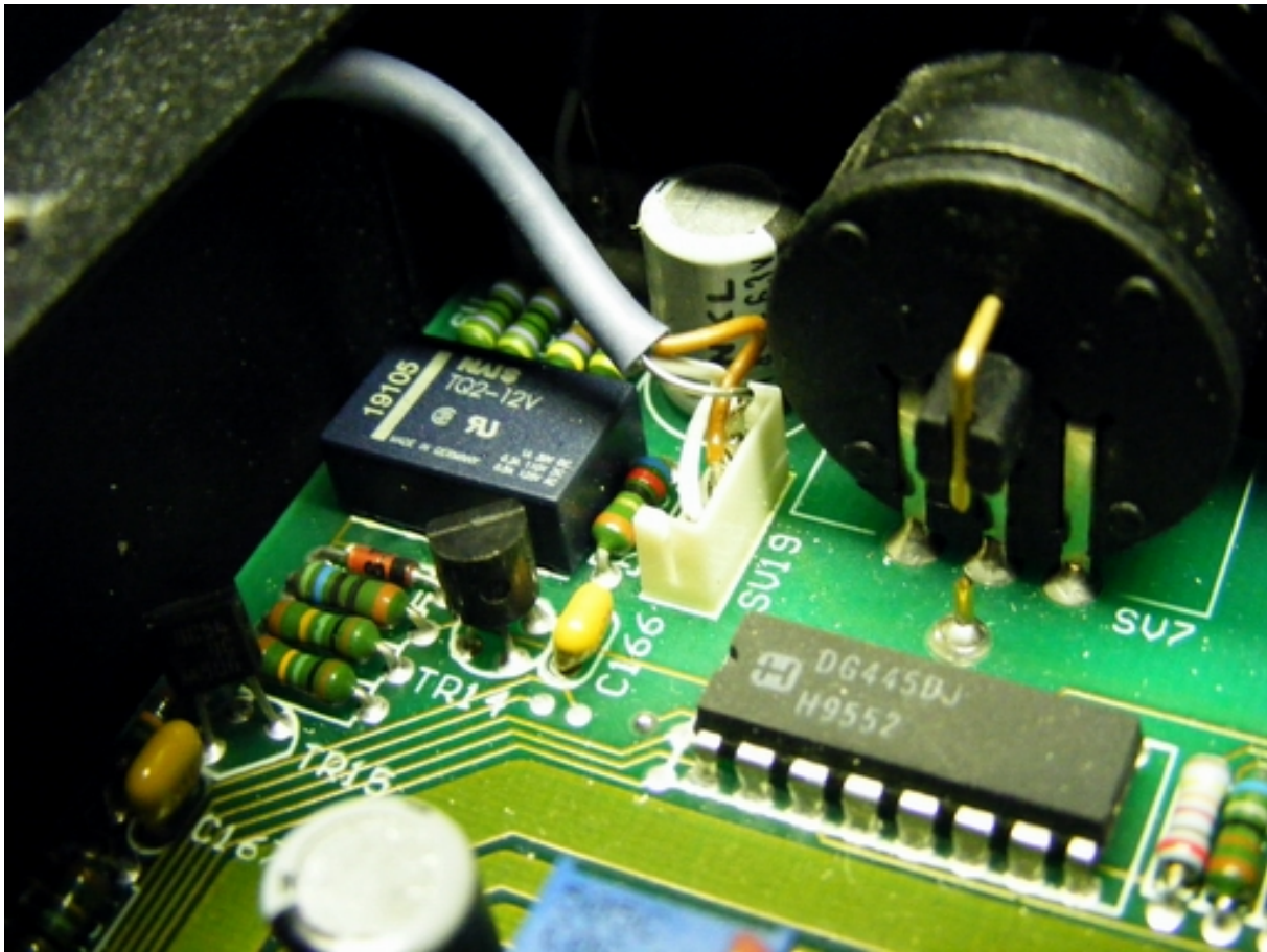
Bild: Leitung zum Übertrager, die von der Eingangsstufe auf der Leiterplatte kommt.
